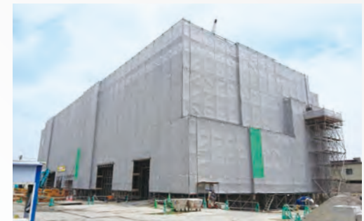
建設中の尼崎事業所
