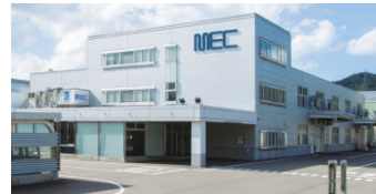
長岡工場外観
