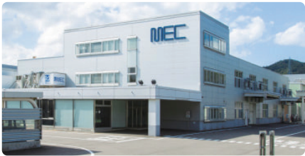
長岡工場外観
