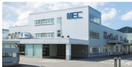
長岡工場外観
